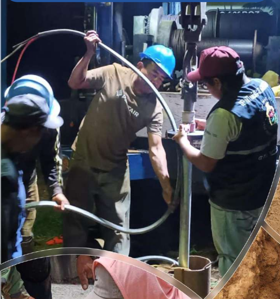
Mantenimiento a bombas de agua
