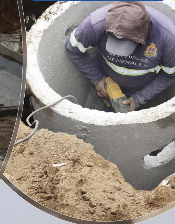
Construcción de pozos de visita
