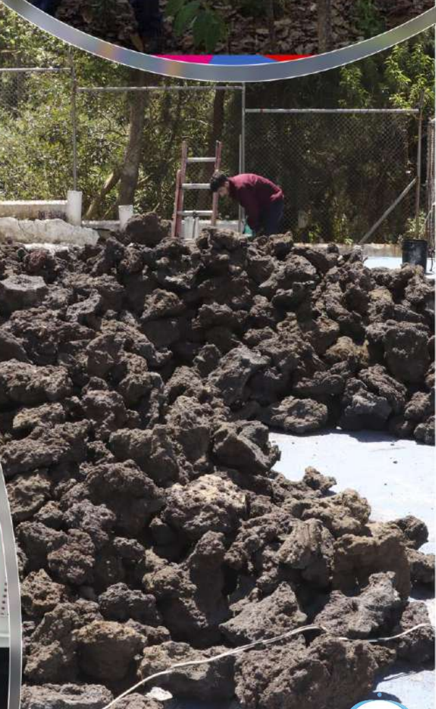
Limpieza de plantas de tratamiento de aguas residuales
